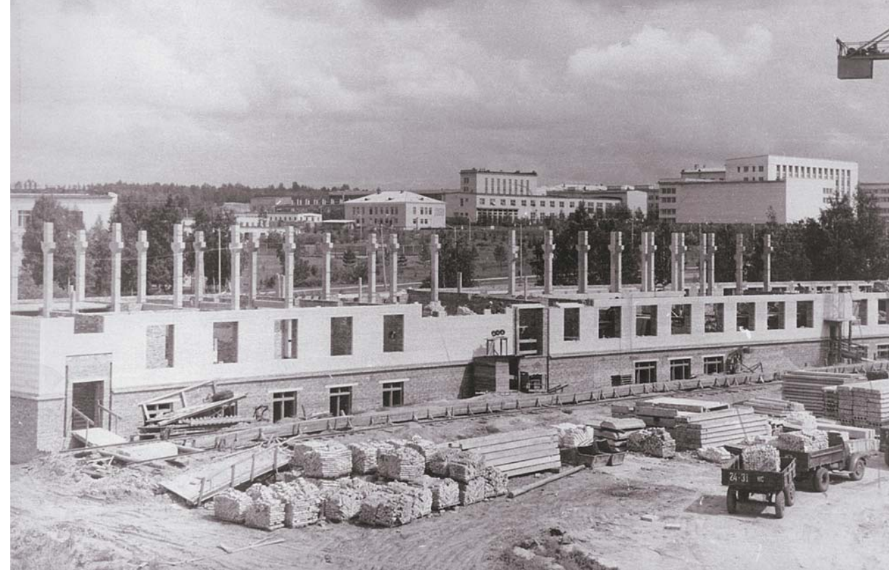
На строительстве корпуса Новосибирского института биоорганической химии СО АН СССР. 1968 г.
