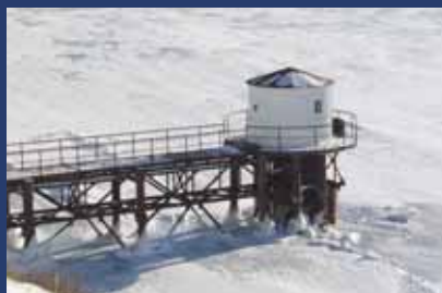
Водозабор Байкальского музея
